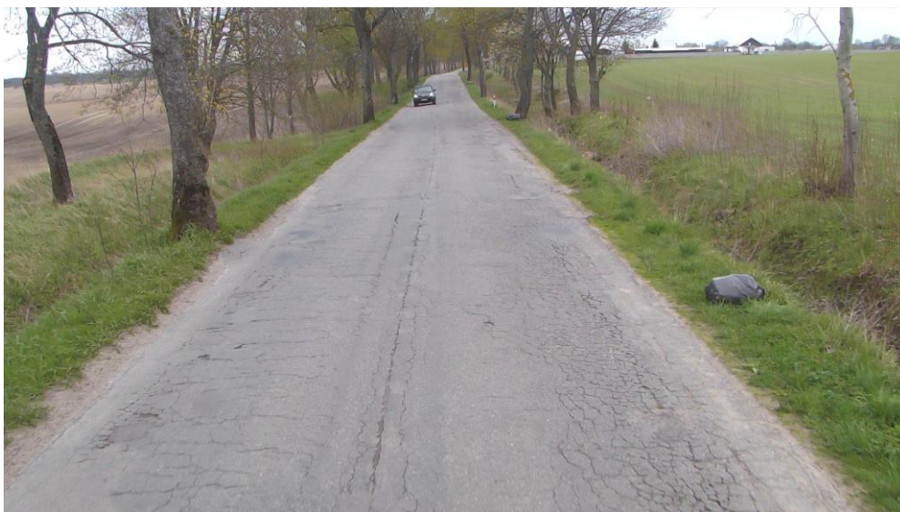
Rysunek 14: Stan zły: spękania siatkowe zajmujące ponad 30% powierzchni
