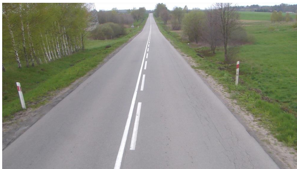
Rysunek 7: Stan dobry: skupiska spękań siatkowych zajmujące do 15% powierzchni
