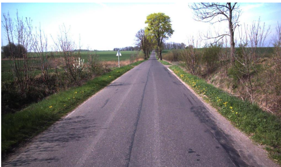
Rysunek 11: Stan ostrzegawczy: łaty nałożone oraz spękania zajmujące do 30% powierzchni
