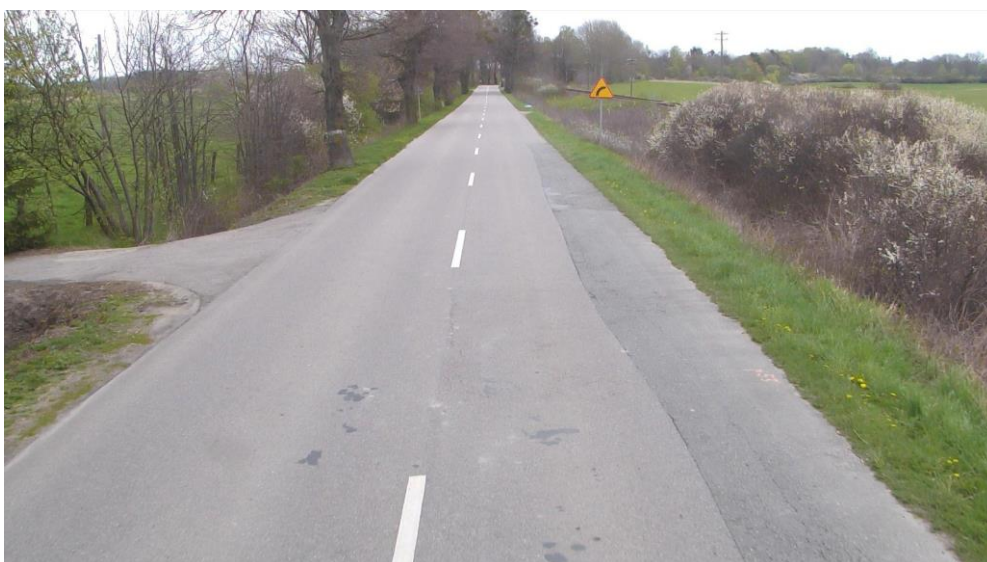
Rysunek 9: Stan ostrzegawczy: łaty wbudowane zajmujące do 30% powierzchni
