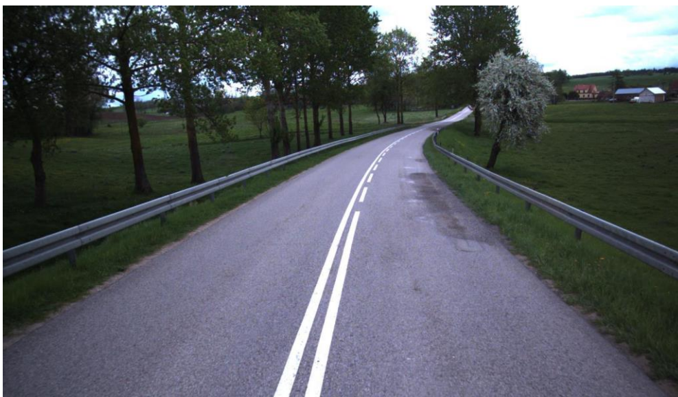
Rysunek 10: Stan ostrzegawczy: łaty nałożone zajmujące do 30% powierzchni
