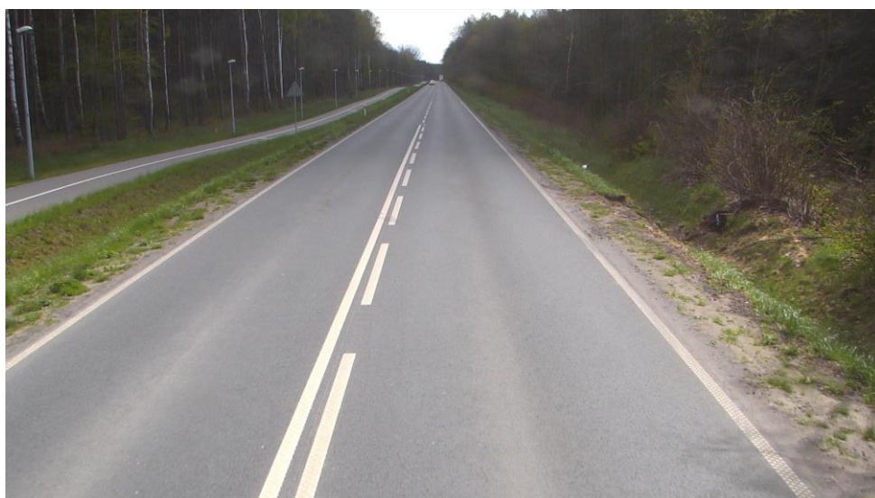
Rysunek 6: Stan dobry: brak uszkodzeń, nawierzchnia drogi jest równa
