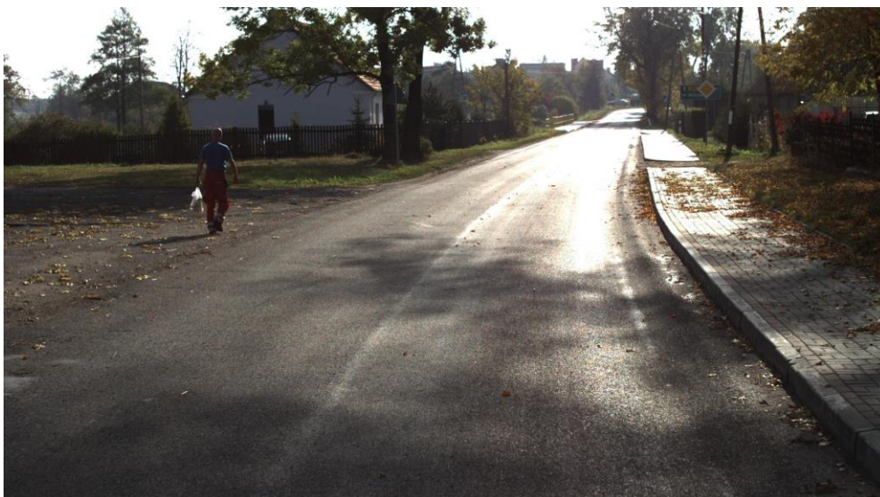
Rysunek 8: Stan ostrzegawczy: brak uszkodzeń powierzchniowych, widoczna nierówność w prawym śladzie koła
