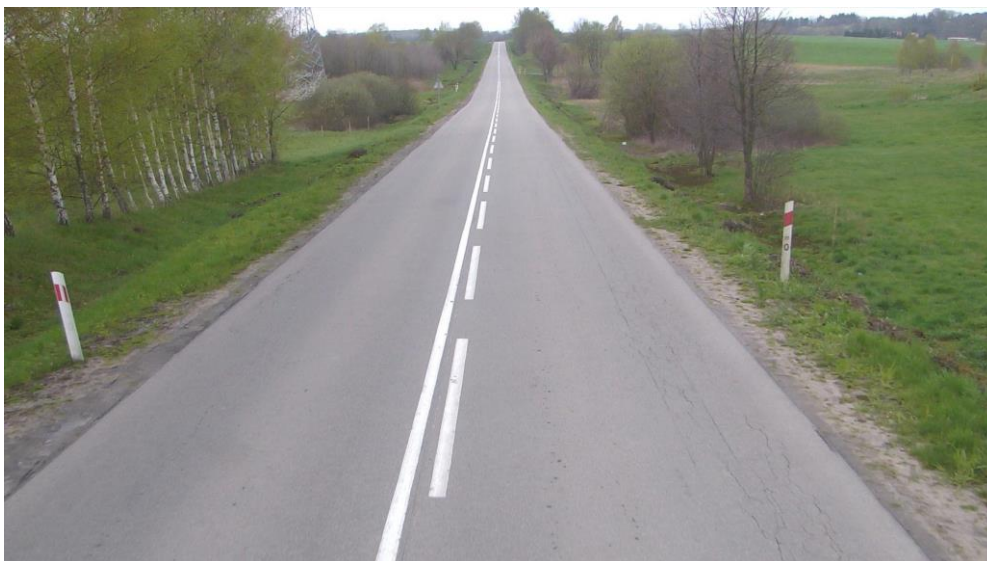
Rysunek 9: Stan dobry: skupiska spękań siatkowych zajmujące do 15% powierzchni
