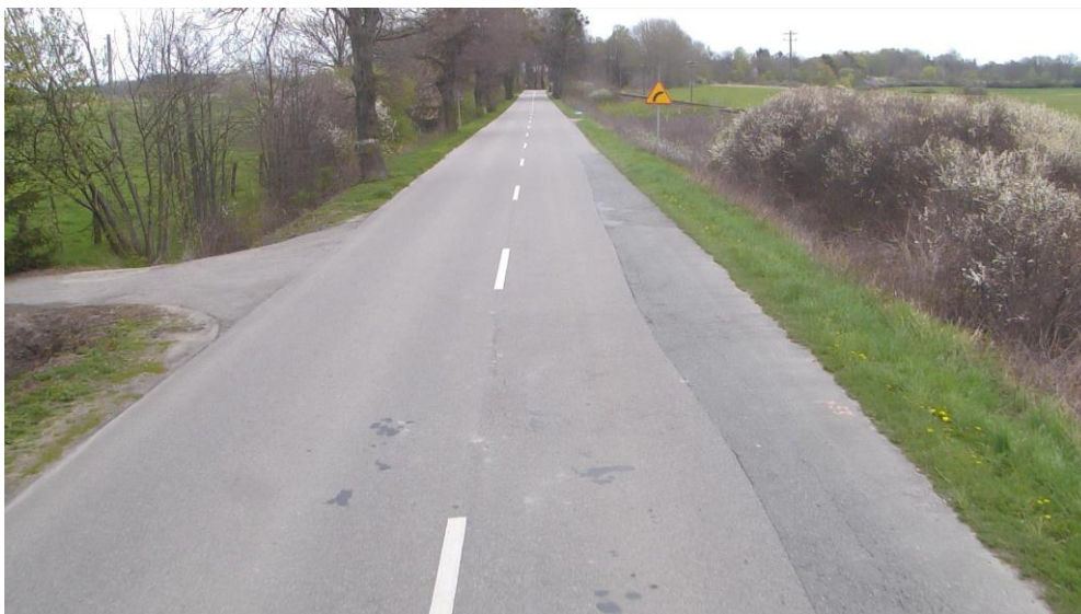
Rysunek 11: Stan ostrzegawczy: łąty wbudowane zajmujące do 30% powierzchni
