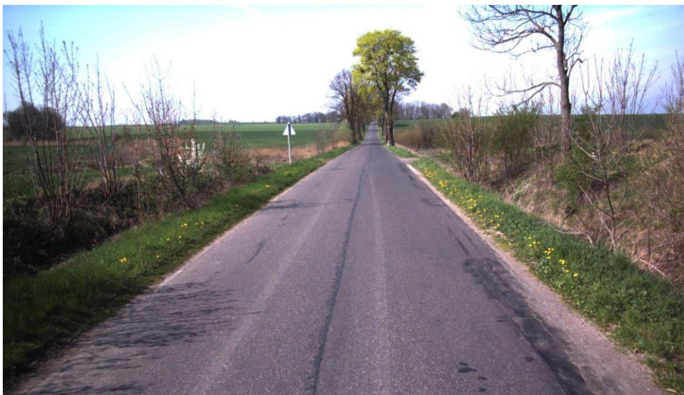
Rysunek 13: Stan ostrzegawczy: łaty nałożone oraz spękania zajmujące do 30% powierzchni
