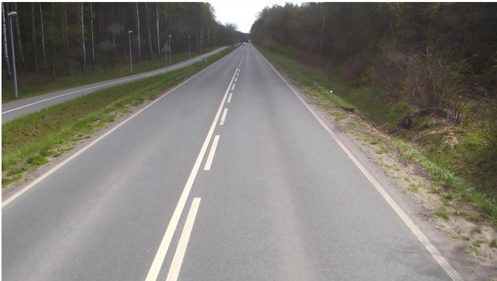
Rysunek 8: Stan dobry: brak uszkodzeń, nawierzchnia drogi jest równa
