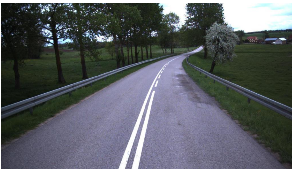
Rysunek 12: Stan ostrzegawczy: łąty nałożone zajmujące do 30% powierzchni
