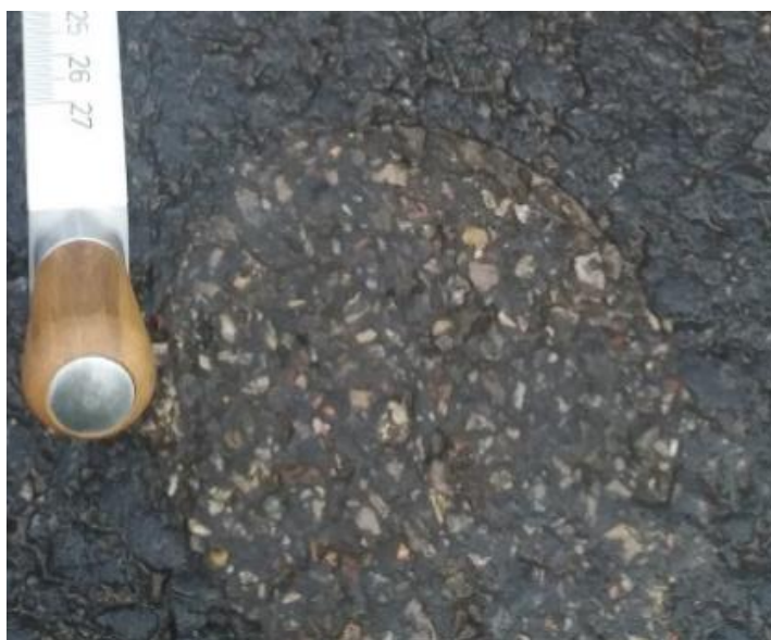
Przykład 5: Prawidłowo zabezpieczone miejsce wykonania odwiertu
