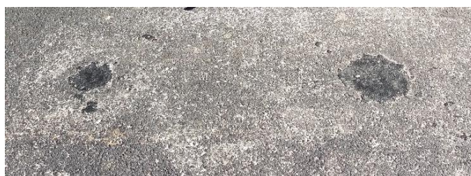
Przykład 7: Nieprawidłowo zabezpieczone miejsce wykonania odwiertu
