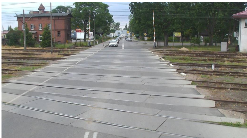
Przykład 2: Przejazd przez tory kolejowe
