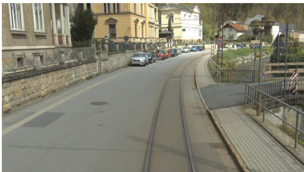
Przykład 3: Przejazd przez tory kolejowe na jezdni
