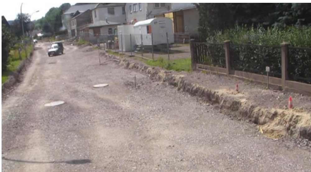
Przykład 10: Przebudowa drogi
