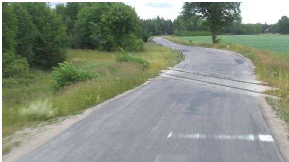
Przykład 1: Przejazd przez tory kolejowe
