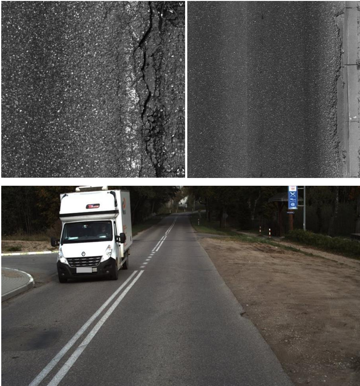
Rysunek 23: Różne przykłady uszkodzeń krawędzi (UK)
