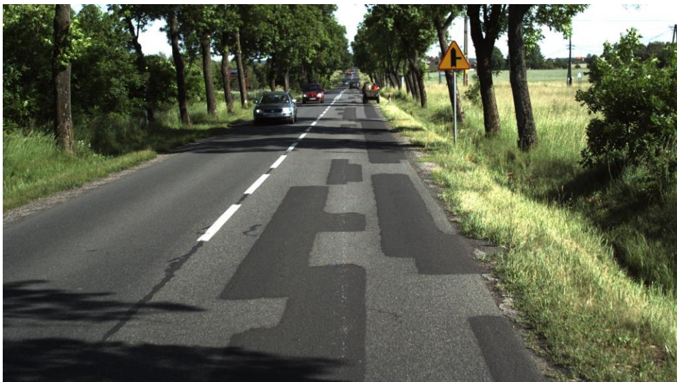
Przykład 1: Łaty nałożone z rozścielacza o regularnych kształtach zidentyfikowane jako wbudowane
