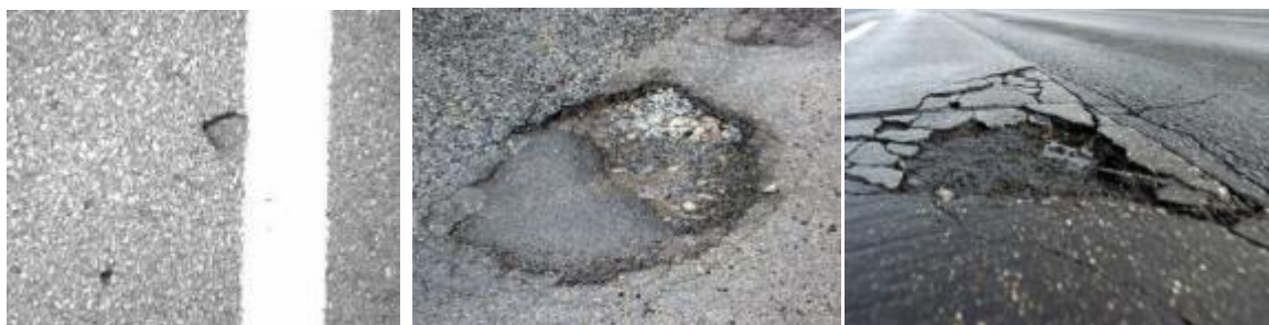
Rysunek 22: Różne przykłady wybojów (WYB)
