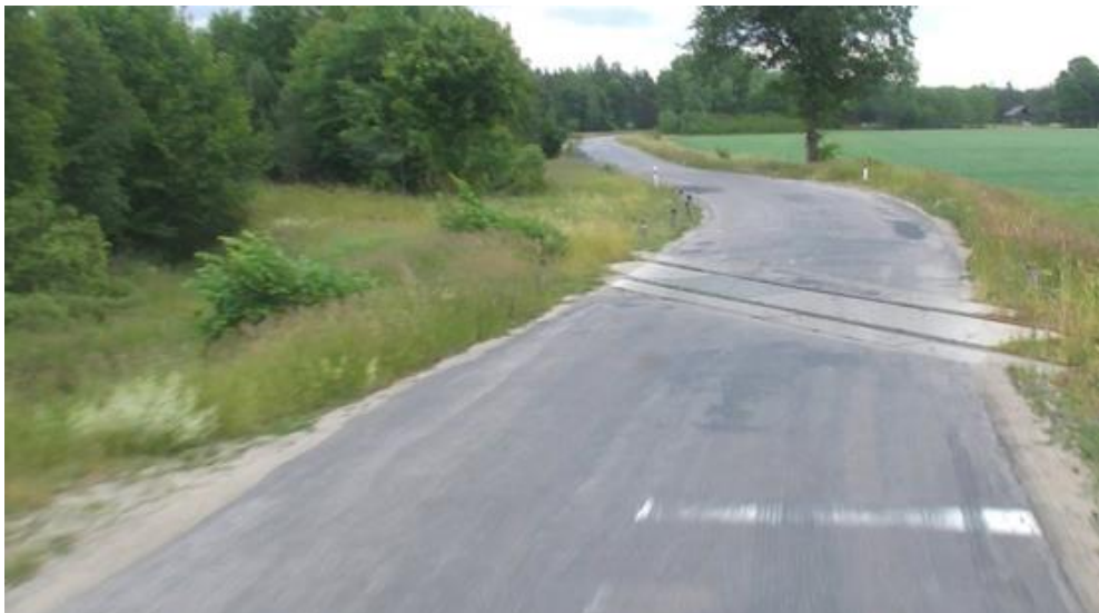
Przykład 7: Przejazd przez tory kolejowe
