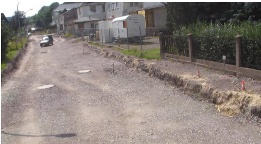
Przykład 16: Przebudowa drogi
