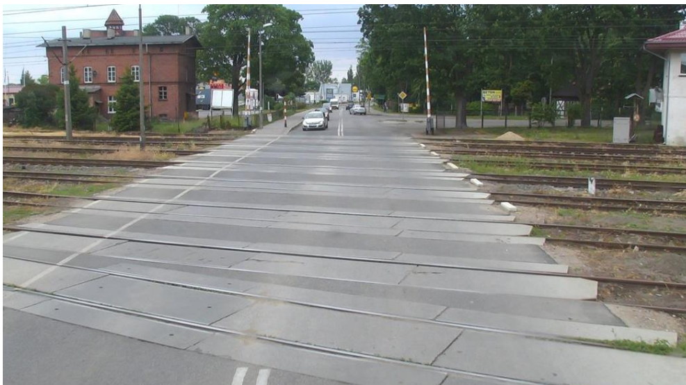
Przykład 8: Przejazd przez tory kolejowe
