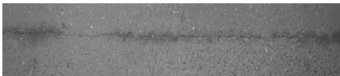
Rysunek 24: Spojenia technologiczne wzdłuż kierunku jazdy widziane na zdjęciu pasa ruchu (fragment)
