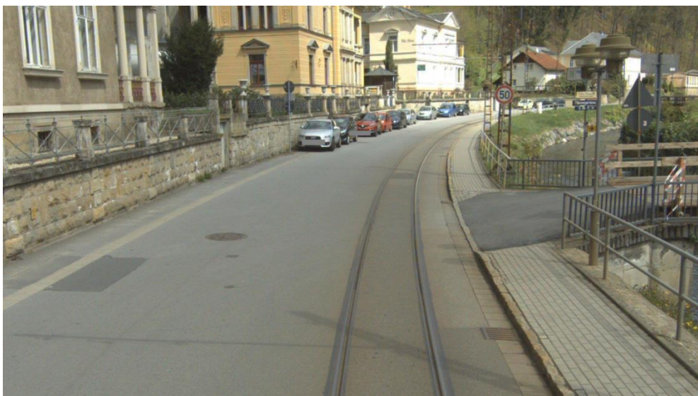
Przykład 9: Przejazd przez tory kolejowe na jezdni
