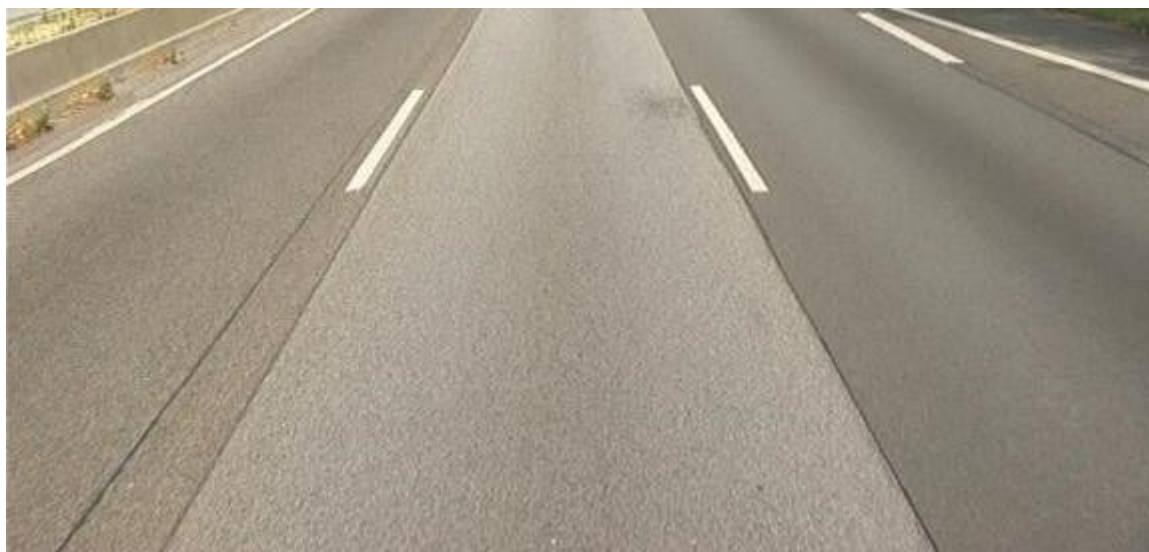
Rysunek 24: Spojenia technologiczne wzdłuż kierunku jazdy widziane na zdjęciu pasa ruchu (fragment)
