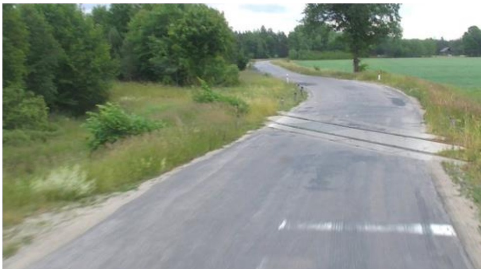
Przykład 1: Przejazd przez tory kolejowe
