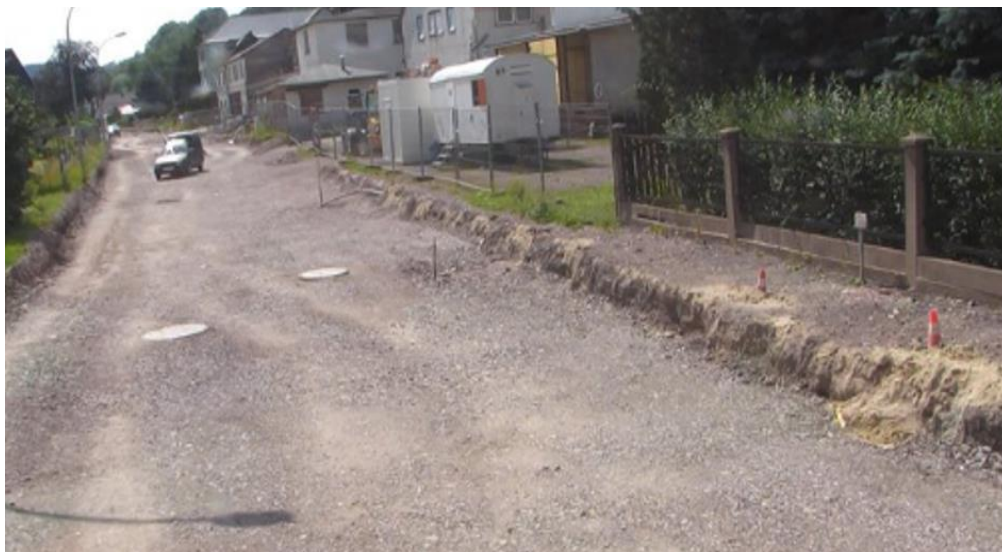
Przykład 9: Przebudowa drogi
