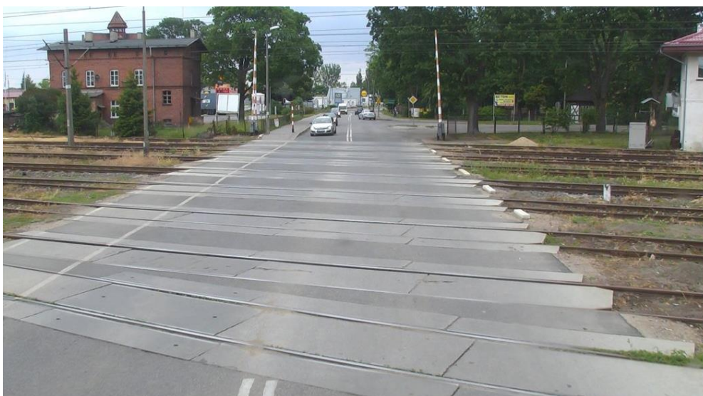
Przykład 2: Przejazd przez tory kolejowe
