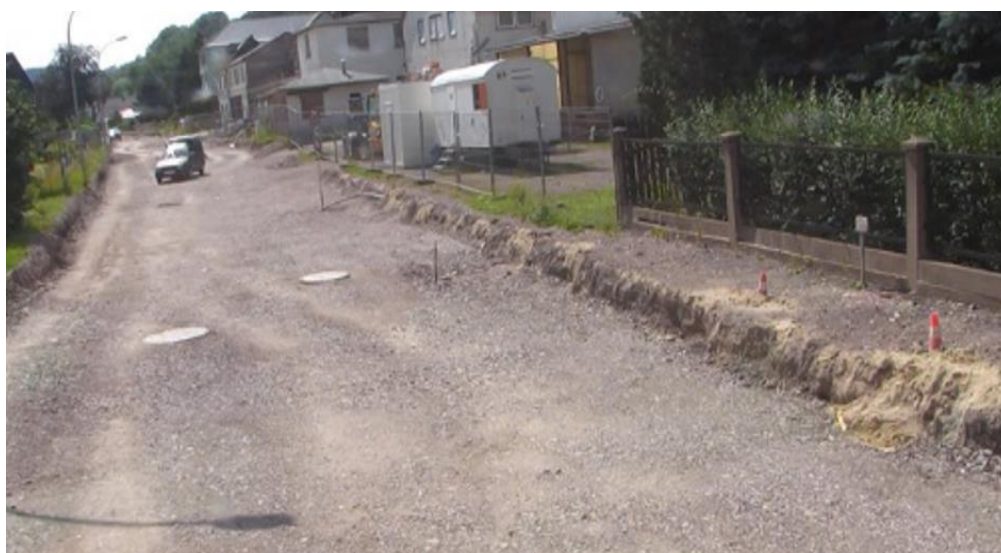
Przykład 10: Przebudowa drogi
