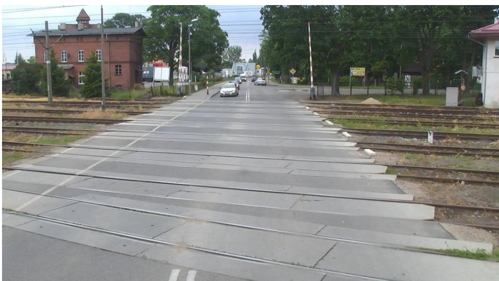
Przykład 2: Przejazd przez tory kolejowe
