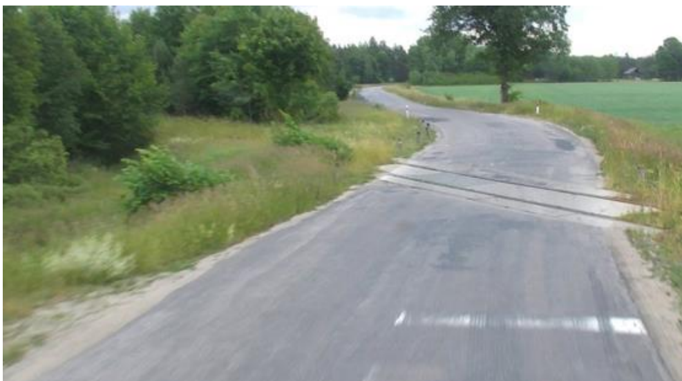
Przykład 1: Przejazd przez tory kolejowe
